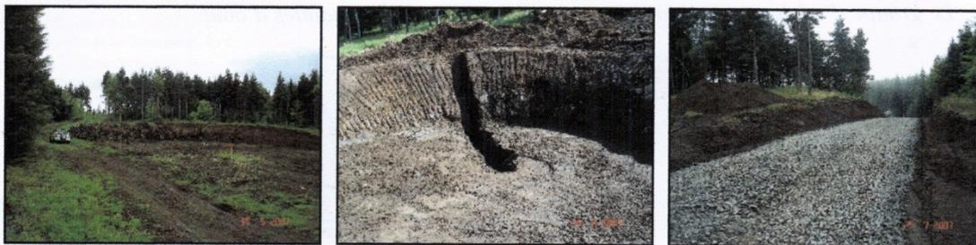
[Photos 1, 2 et 3](#) : dessouchage, réalisation des excavations des massifs, empierrement des pistes et des plates formes
