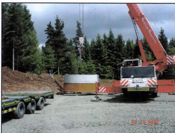
Photo 4 : déchargement de l'insert sur une plate forme
