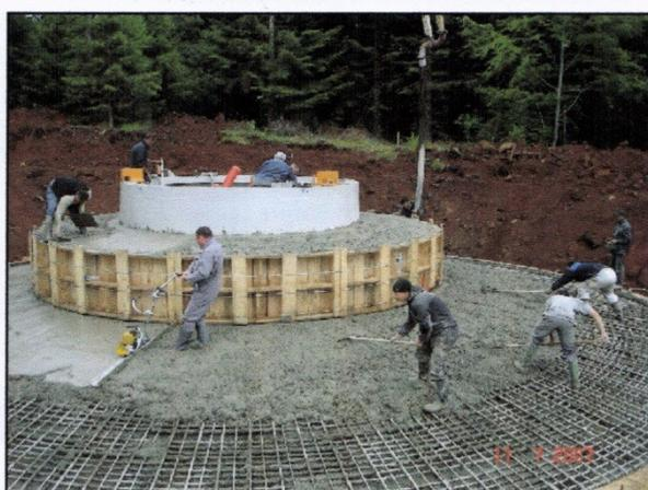
Photo 7 : opération de coulage de béton (400 m<sup>3</sup>)
