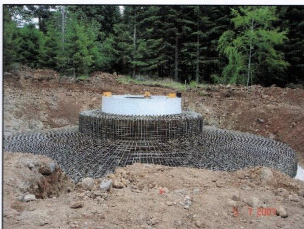
Photo 6 : ferrailage du massif (40 tonnes)
