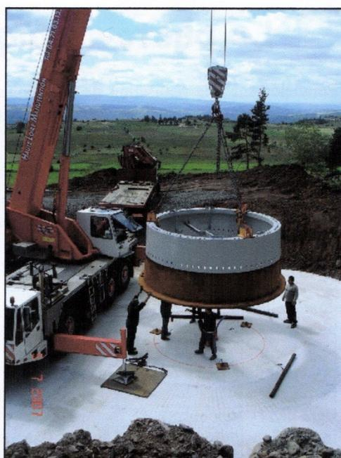
Photo 5 : mise en place de l'insert sur le béton de propreté du massif
